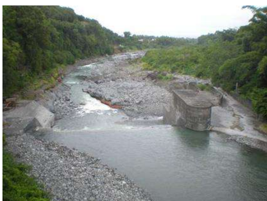
Barrage situé dans le secteur amont de la rivière du Mât (Source : Biotope).
