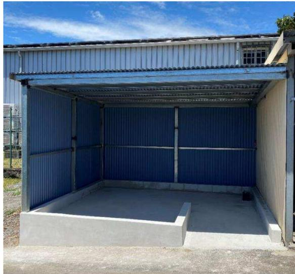
Figure 4 : Auvent à batterie
